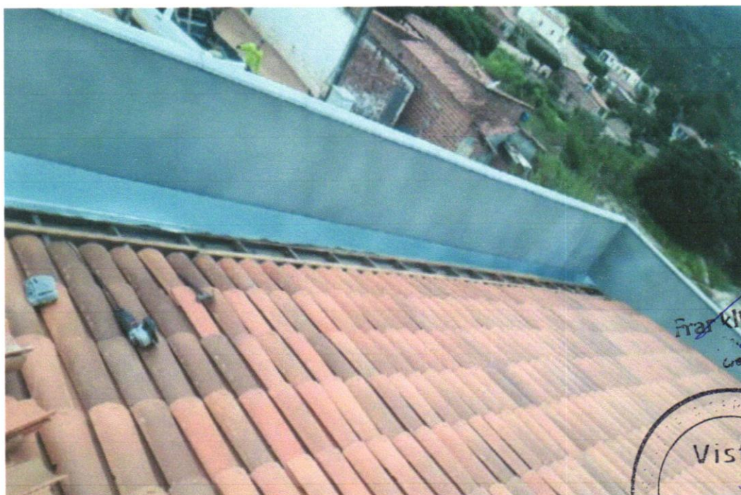
FOTO 08 – Telhamento com telha cerâmica tipo canal, comum, cor vermelha, Itabaiana ou similar
