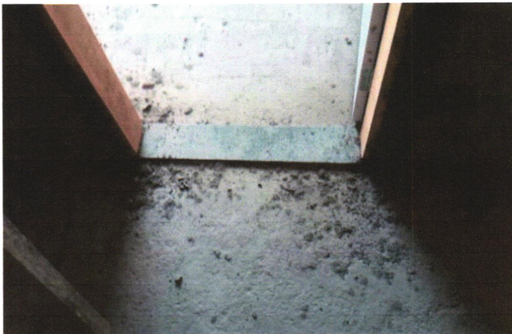
FOTO 02 – SOLEIRA EM GRANITO, LARGURA 15 CM, ESPESSURA 2,0 CM. AF_09/2020
