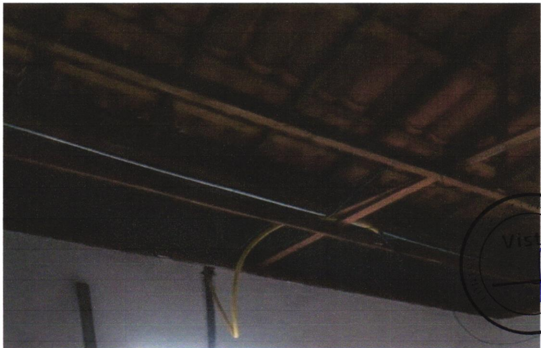
Foto 36- CABO DE COBRE FLEXÍVEL ISOLADO, 1,5 MM 2 , ANTI-CHAMA 450/750 V, PARA CIRCUITOS TERMINAIS - FORNECIMENTO E INSTALAÇÃO. AF_12/2015
