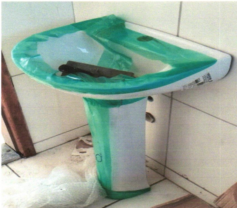
Foto 44- LAVATÓRIO LOUÇA BRANCA COM COLUNA, 45 X 55CM OU EQUIVALENTE, PADRÃO MÉDIO - FORNECIMENTO E INSTALAÇÃO. AF_01/2020
