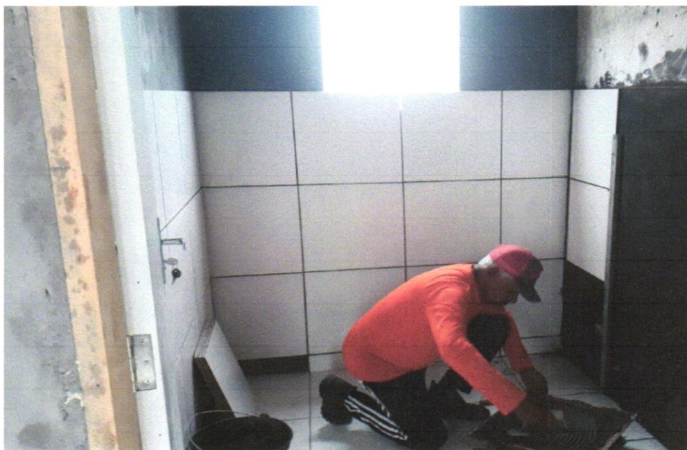
Foto 29 - REVESTIMENTO CERÂMICO PARA PAREDES INTERNAS COM PLACAS TIPO ESMALTADA EXTRA DE DIMENSÕES 33X45 CM APLICADAS EM AMBIENTES DE ÁREA MAIOR QUE 5 M 2 A MEIA ALTURA DAS PAREDES. AF_06/2014
