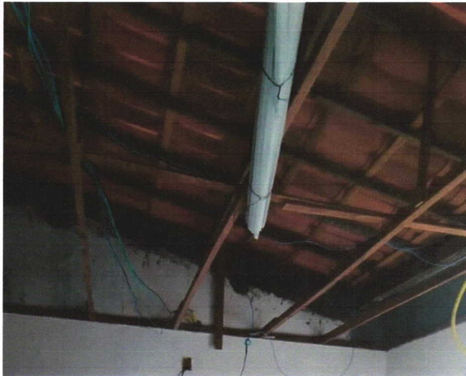
Foto 37 - CABO DE COBRE FLEXÍVEL ISOLADO, 2,5 MM 2 , ANTI-CHAMA 450/750 V, PARA CIRCUITOS TERMINAIS - FORNECIMENTO E INSTALAÇÃO. AF_12/2015
