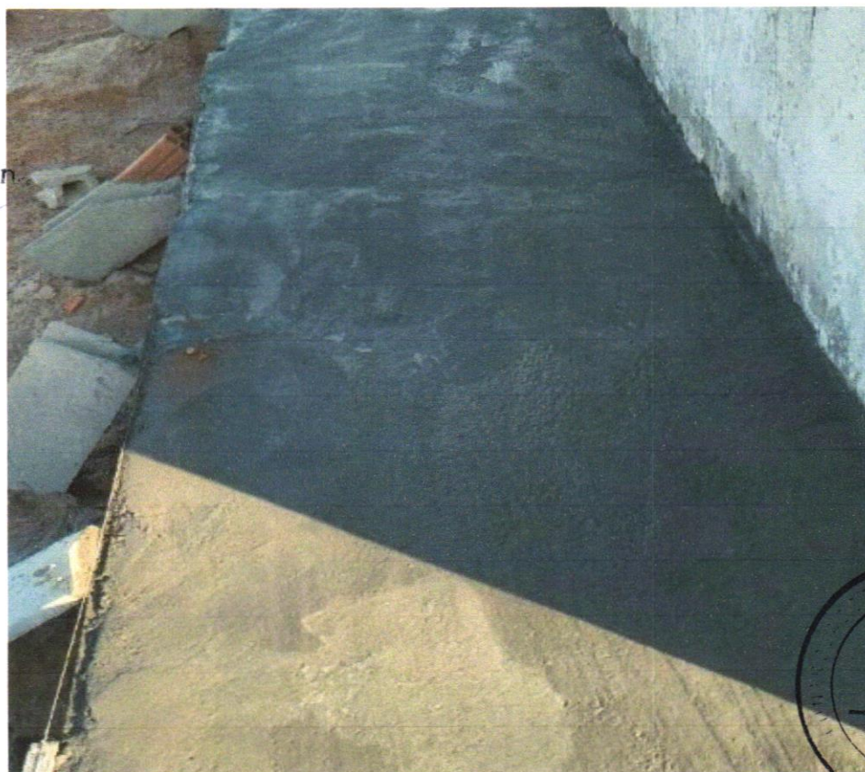
FOTO 10 – EXECUÇÃO DE PASSEIO (CALÇADA) OU PISO DE CONCRETO COM CONCRETO MOLDADO IN LOCO, USINADO, ACABAMENTO CONVENCIONAL, NÃO ARMADO. AF_07/201
