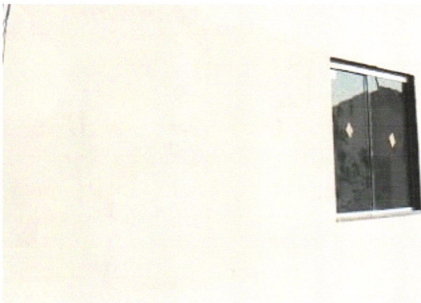
Foto 42- JANELA DE ALUMÍNIO DE CORRER COM 2 FOLHAS PARA VIDROS, COM VIDROS, BATENTE, ACABAMENTO COM ACETATO OU BRILHANTE E FERRAGENS. EXCLUSIVE ALIZAR E CONTRAMARCO. FORNECIMENTO E INSTALAÇÃO. AF_12/2019
