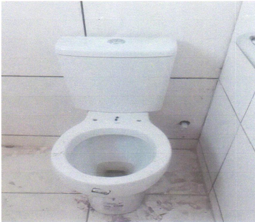
Foto 43 - VASO SANITARIO SIFONADO CONVENCIONAL COM LOUÇA BRANCA - FORNECIMENTO E INSTALAÇÃO. AF_01/2020
