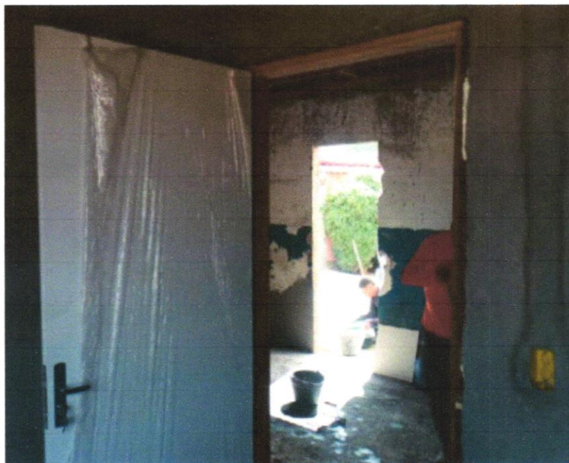
FOTO 05 – KIT DE PORTA-PRONTA DE MADEIRA EM ACABAMENTO MELAMÍNICO BRANCO, FOLHA LEVE OU MÉDIA, 90X210, EXCLUSIVE FECHADURA, FIXAÇÃO COM PREENCHIMENTO TOTAL DE ESPUMA EXPANSIVA - FORNECIMENTO E INSTALAÇÃO. AF_12/2019
