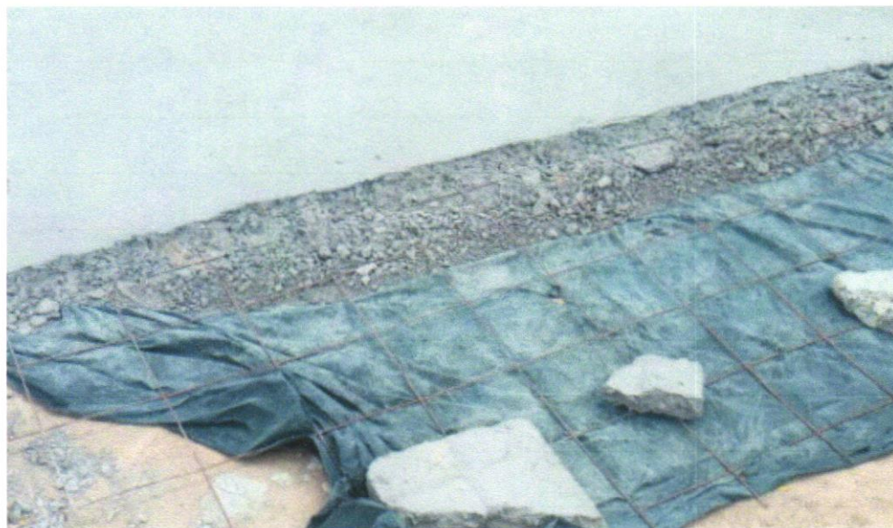
FOTO 09 – APLICAÇÃO DE LONA PLÁSTICA PARA EXECUÇÃO DE PAVIMENTOS DE CONCRETO. AF_04/2022
