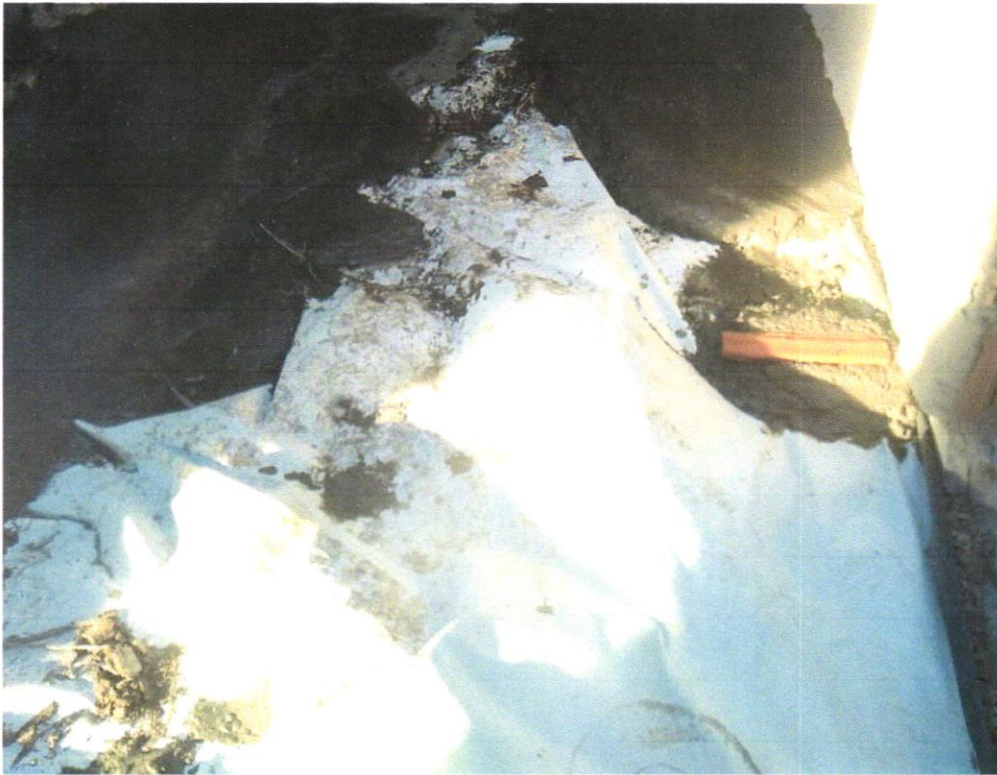
Foto 27 - APLICAÇÃO DE LONA PLÁSTICA PARA EXECUÇÃO DE PAVIMENTOS DE CONCRETO. AF_04/2022
