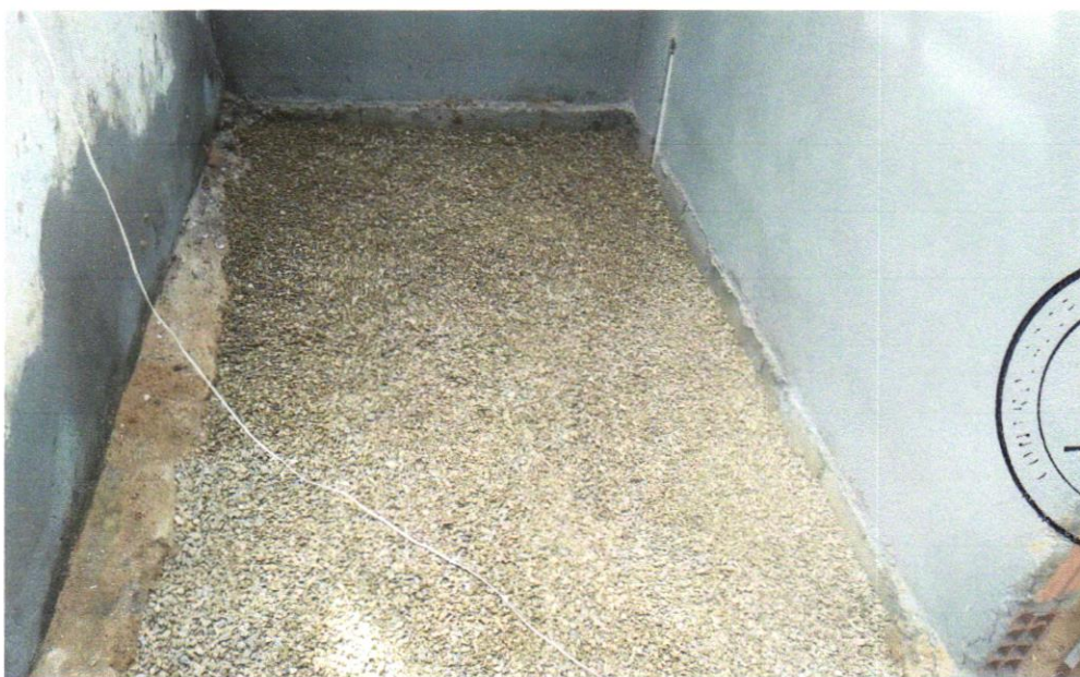
Foto 26- Lastro de brita graduada apiloada e=10cm
