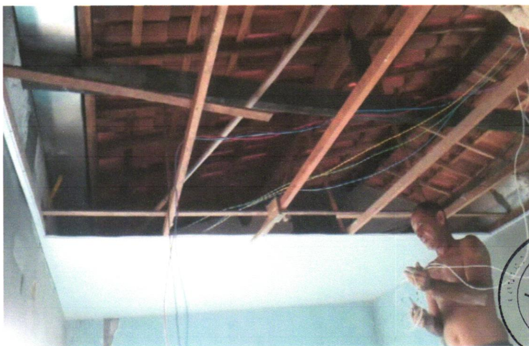
Foto 20- CABO DE COBRE FLEXÍVEL ISOLADO, 4 MM 2 , ANTI-CHAMA 0,6/1,0 KV, PARA CIRCUITOS TERMINAIS - FORNECIMENTO E INSTALAÇÃO. AF_12/2015
