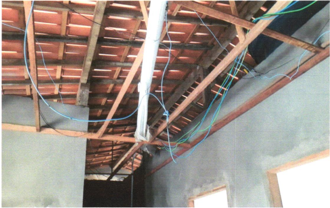
Foto 35 - CABO DE COBRE FLEXÍVEL ISOLADO, 4 MM 2 , ANTI-CHAMA 0,6/1,0 KV, PARA CIRCUITOS TERMINAIS - FORNECIMENTO E INSTALAÇÃO. AF_12/2015
