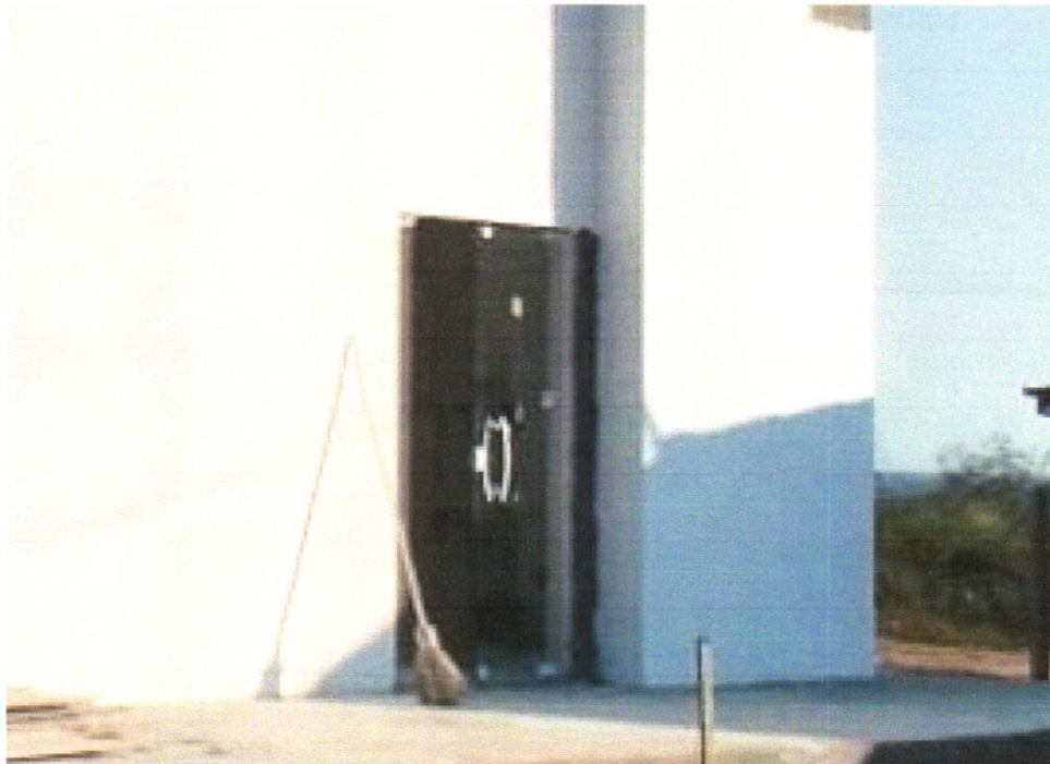
Foto 41 - Porta em vidro temperado 10mm, incolor, inclusive ferragens de fixação e instalação, exclusive puxador - Rev 01_10/2021
