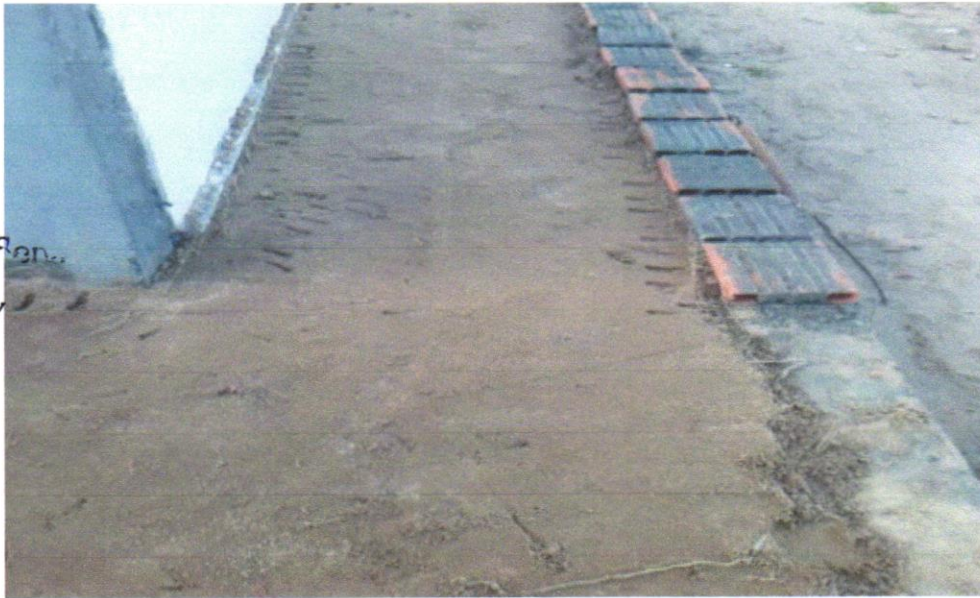
FOTO 01 – ATERRO MANUAL DE VALAS COM AREIA PARA ATERRO E COMPACTAÇÃO MECANIZADA. AF_05/2016
